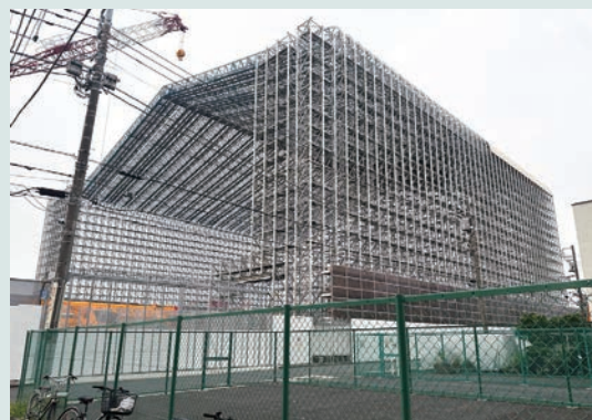
撤去中の北清掃工場全覆い仮設テント
