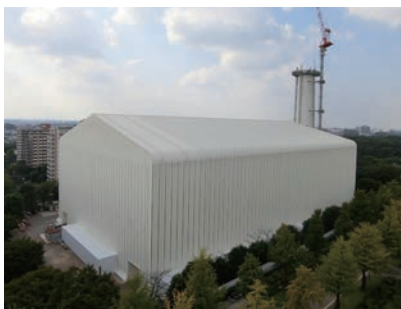
光が丘清掃工場の全覆い仮設テント （清掃一組のホームページより）
