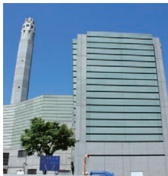
2022年度から建替事業が始まる志茂一丁目の北清掃工場
